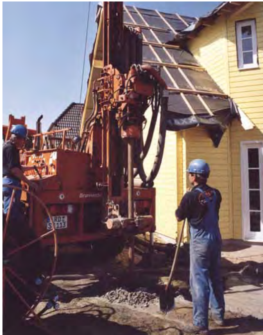
Abbildungen 10 und 11: Bohrgerät (links) und Bohrkopf (Flügelmeißel und Rollenmeißel, rechts)
