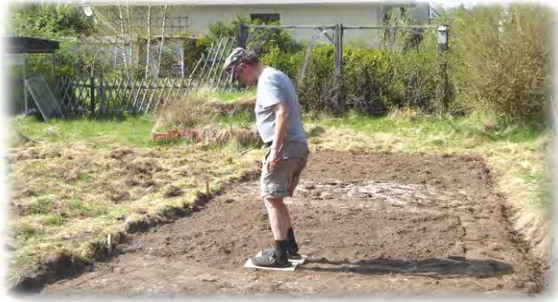
Ca. 125 qm Fläche mit aufgetragenem und vermischtem Magersand im stillgelegten Kleingarten.
