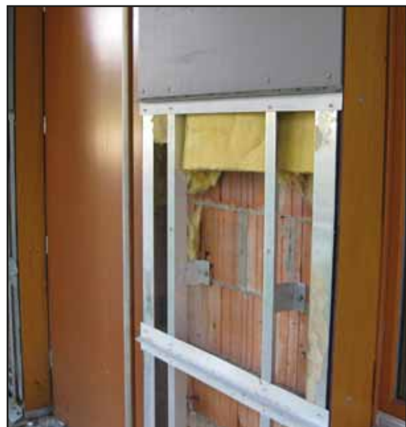
Abb. 6: Vorgehängte hinterlüftete Fassade (© HTW Dresden)
