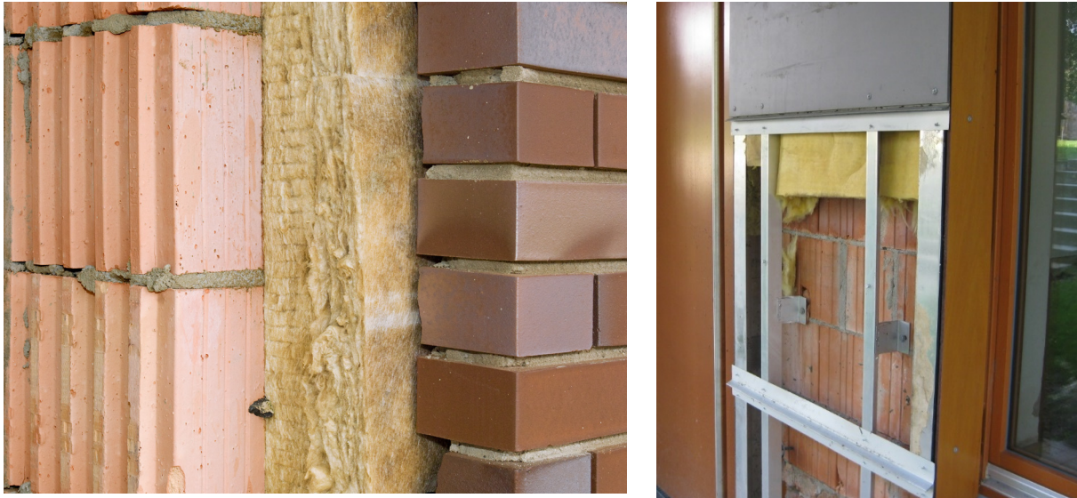
Abbildung 10: Links: Zweischaliges Mauerwerk mit Kerndämmung (Mineralwolle). Die gesättigte Dämmstoffschicht ist nach einem Überflutungsereignis sehr schwer zugänglich. © Alterfalter – stock.adobe.com. Rechts: Vorgehängte hinterlüftete Fassade. Die Dämmstoffebene ist durch die Demontierbarkeit der Fassadenelemente vergleichsweise einfach erreichbar. © Sebastian Golz.
