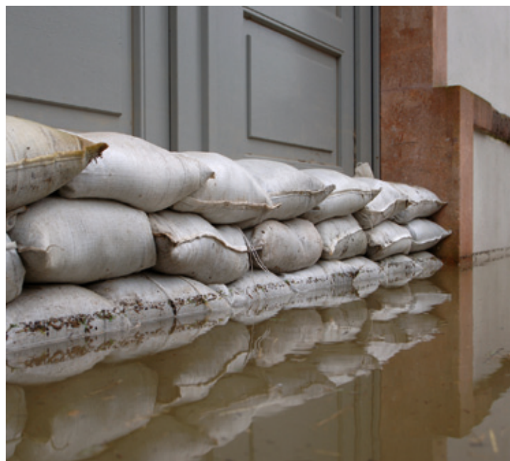
Notfallmäßiger Objektschutz mit Sandsäcken
