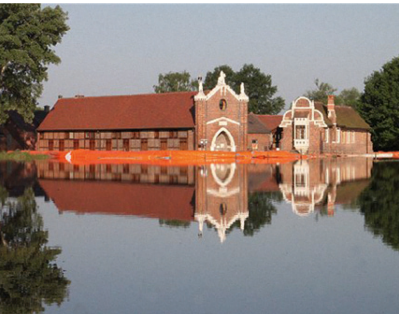
Objektschutz mit mobilem wassergefülltem Schlauchsystem
