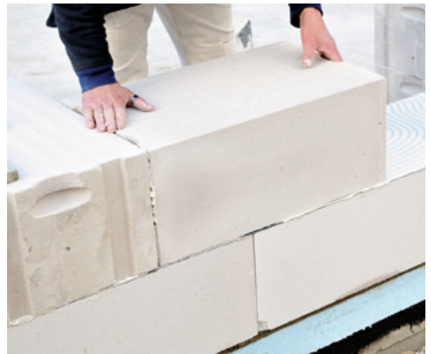
Mauerwerk aus Porenbeton-Plansteinen
