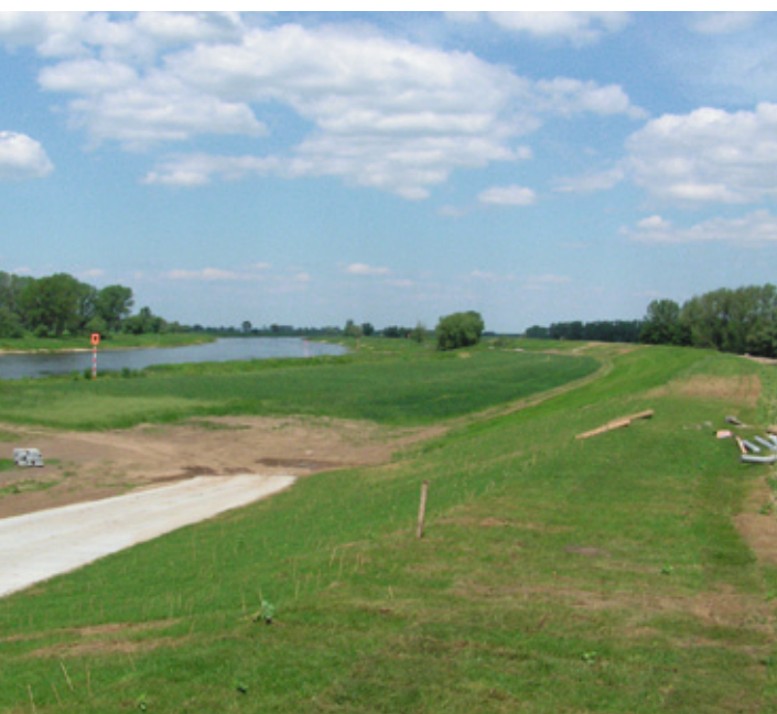
Sanierter Hochwasserschutzdeich an der Elbe
