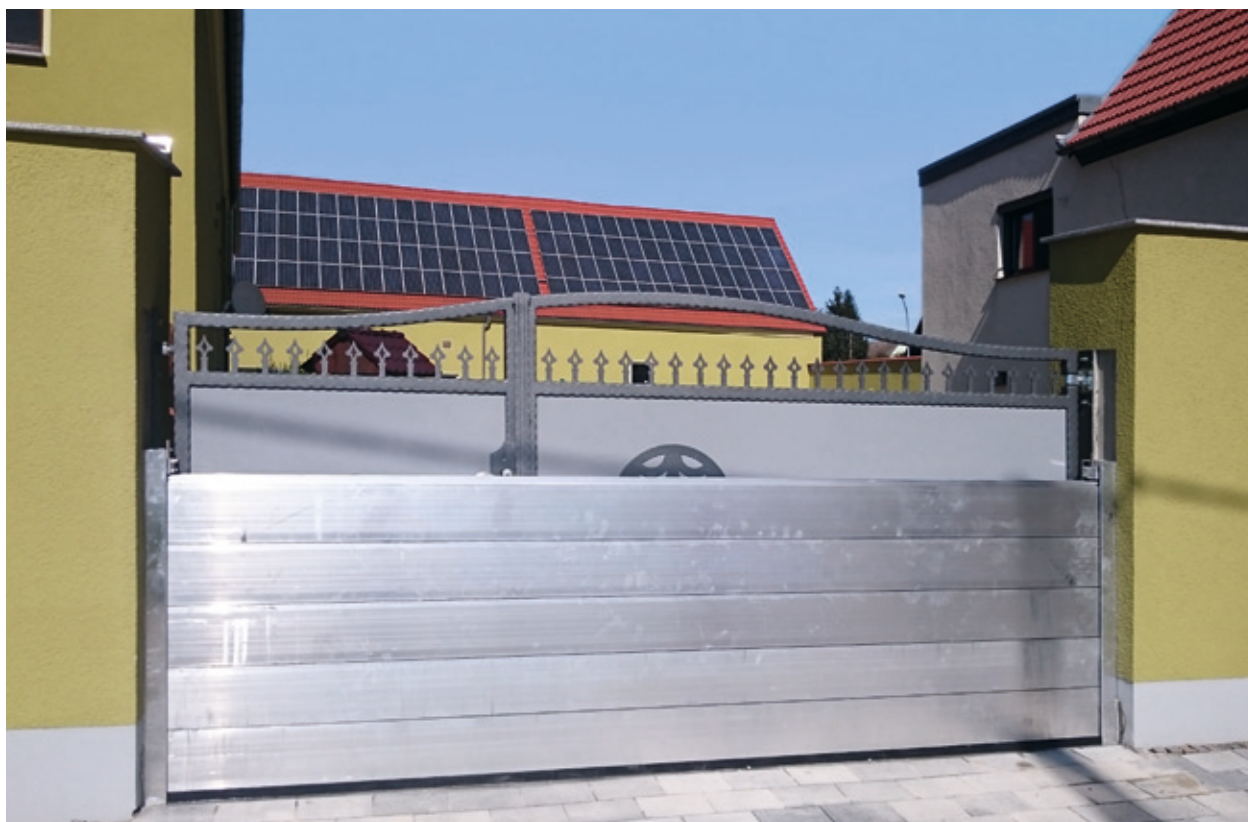
Mobiler Hochwasserschutz mit Dammbalken
