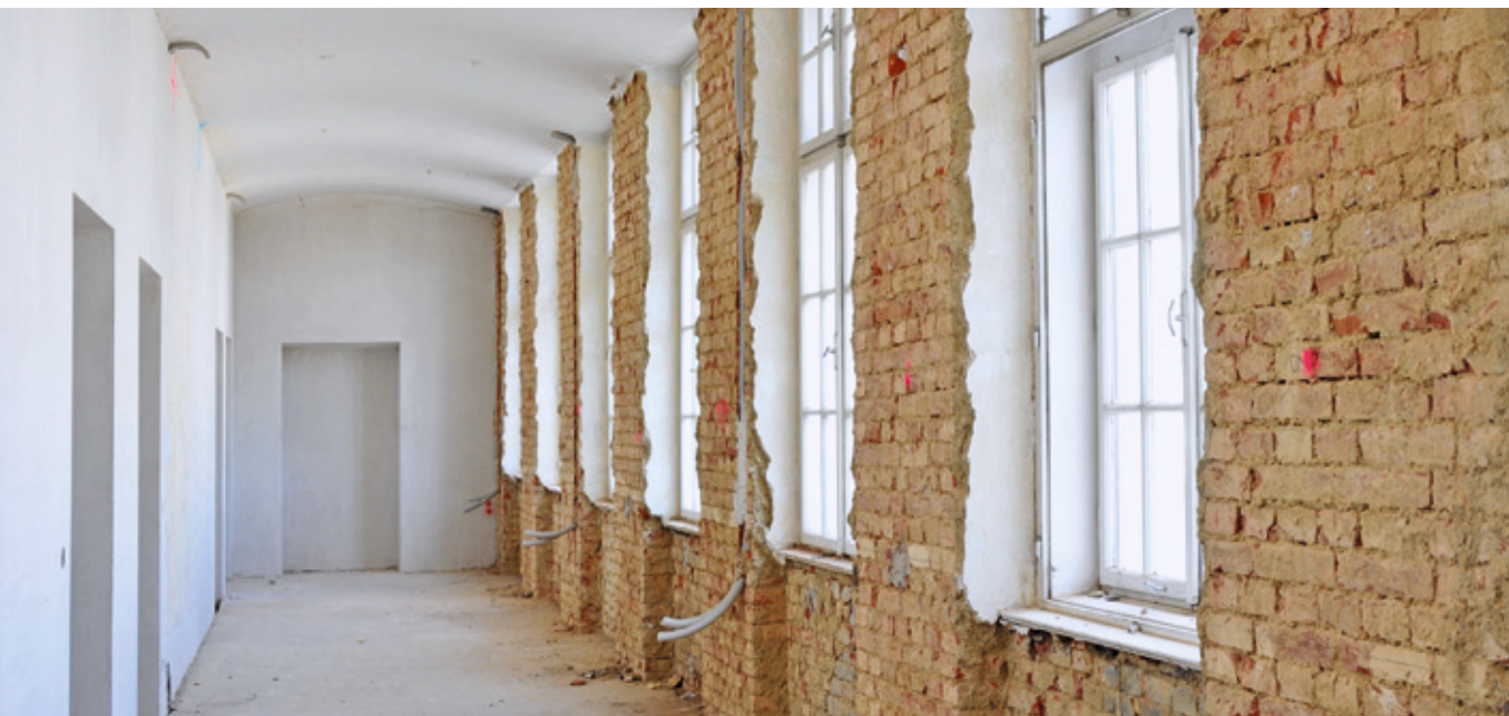
Entfernter Putz zur besseren Trocknung einer Außenwand
