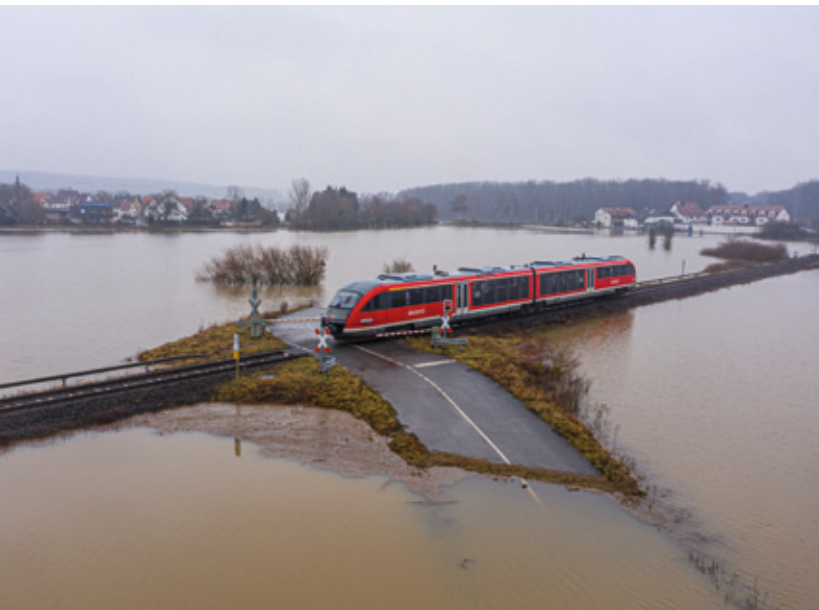
Hochwasser nach extremen Niederschlägen
