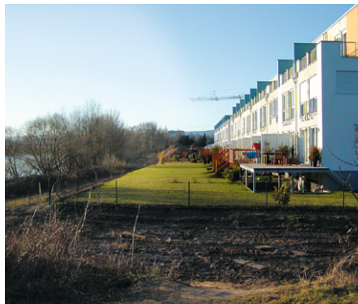
Hochwasserangepasste Bauweise mit erhöhtem Erdgeschoss
