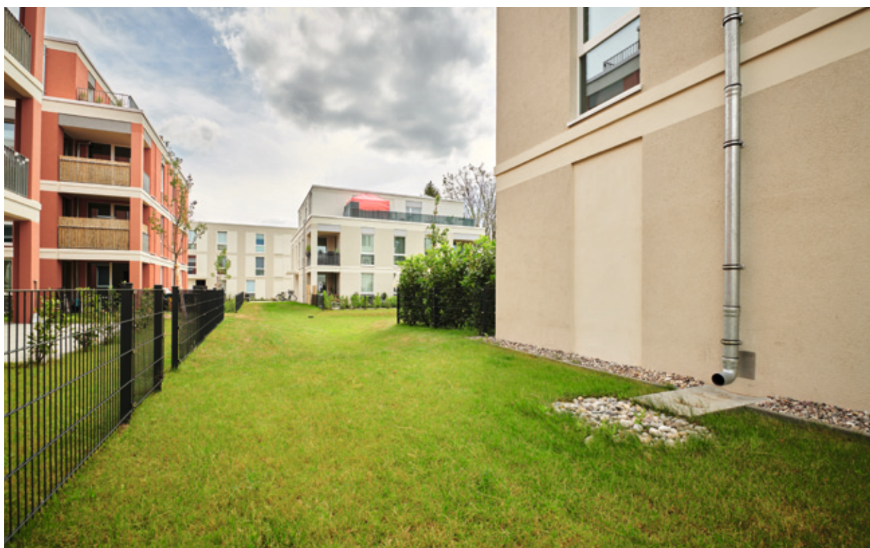
Dezentrale Rückhaltung von Niederschlagswasser
