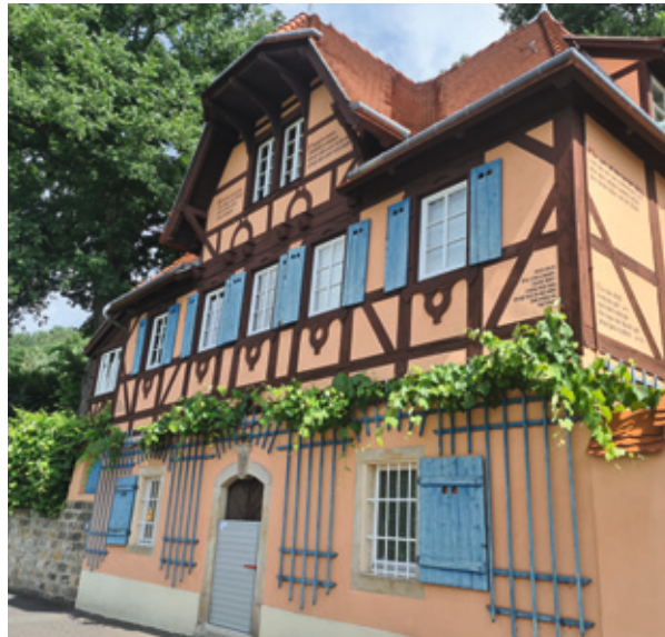
Denkmalschutz mit Hochwasserschutz
