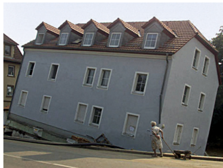
Unterspültes Haus an der Weißeritz
